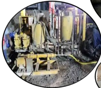
Inyección de Suelos
