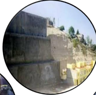
Obras de Retención con Suelo Cemento / Muros Gavión
