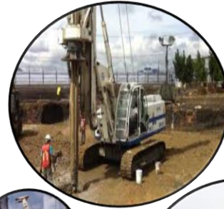
Perforación, Armado y Colado de Pilas de Cimentación
