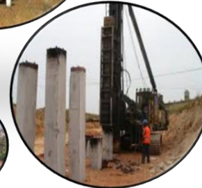
Hincado de Pilotes y Tablestacas
